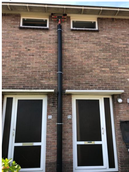
Figuur 6.4 – Voorbeeld aansluitleiding via gevel
