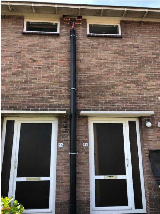
Figuur 6.4 – Voorbeeld aansluitleiding via gevel
